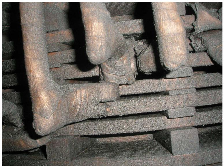
*Schlammablagerungen lassen das Isolationspapier schneller altern und beeinträchtigen so die Betriebssicherheit*
